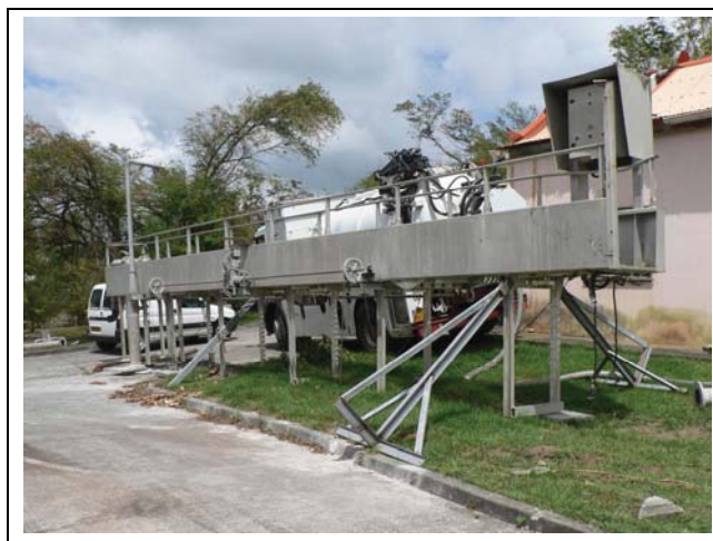
Photo 1. Poste de relevage
