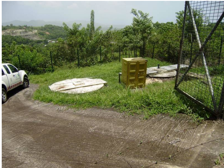
Photo 1 : Vue de la station de Fond Masson
