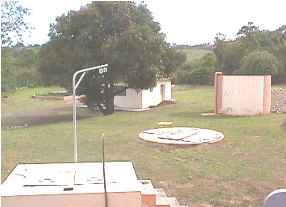
Station de traitement d'eaux usées de Tartane
