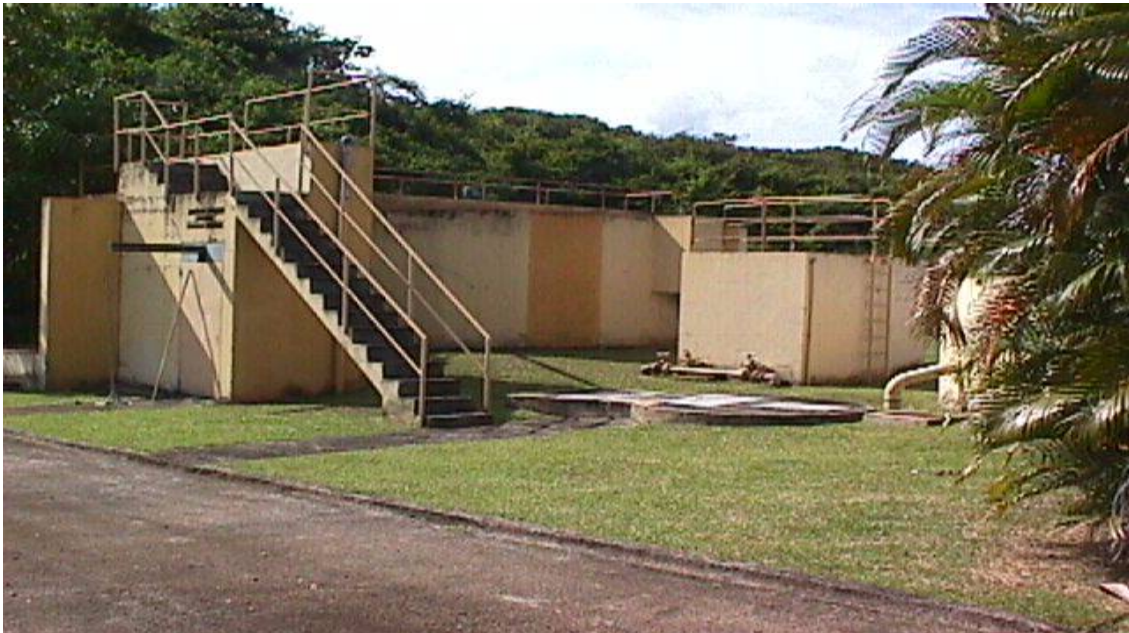
Station de traitement d'eaux usées du Bac
