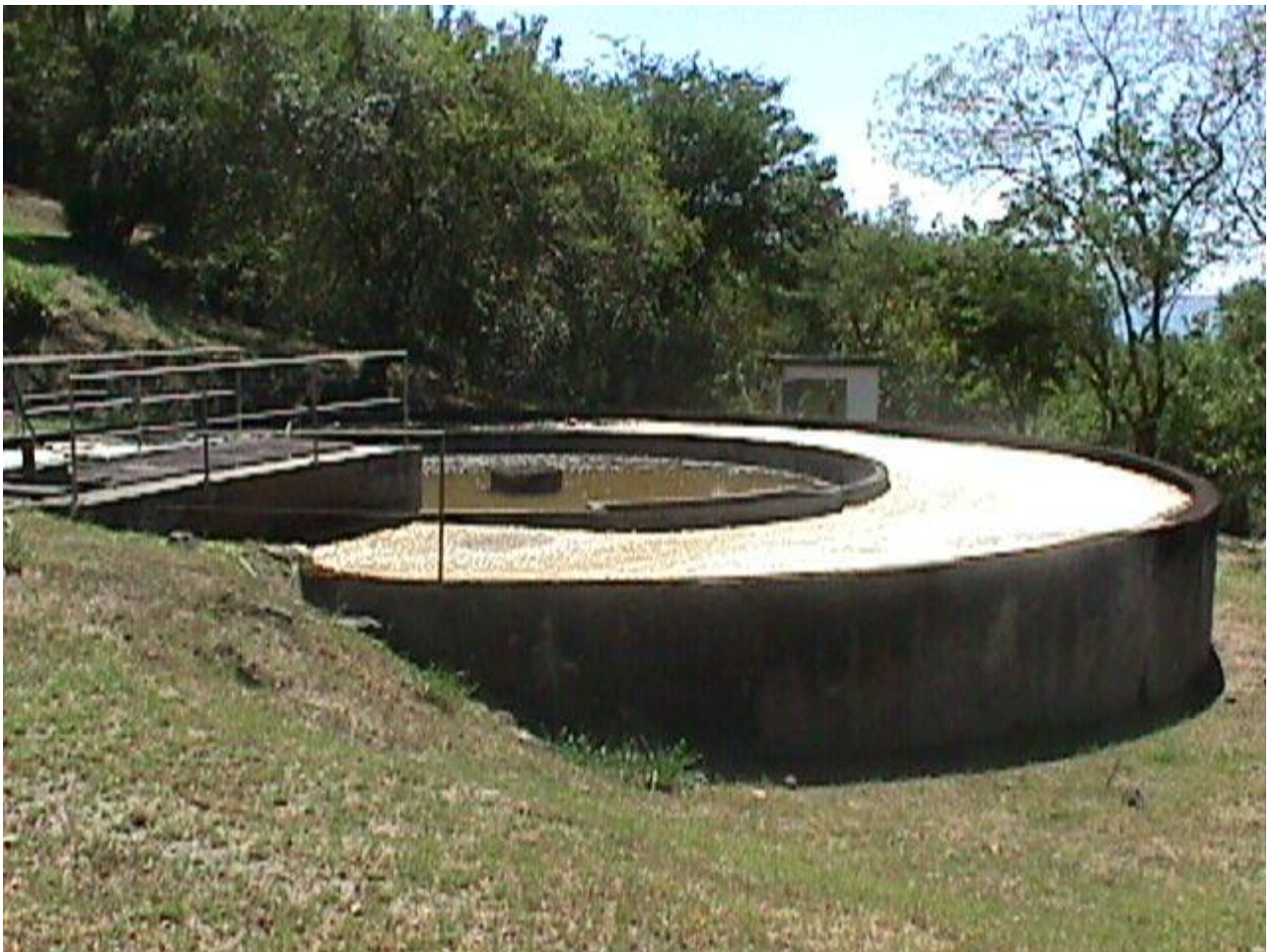
Station de traitement des eaux usées de La Cherry
