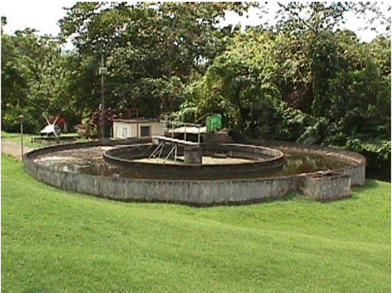
STATION DE TRAITEMENT DES EAUX USEES DU BOURG
