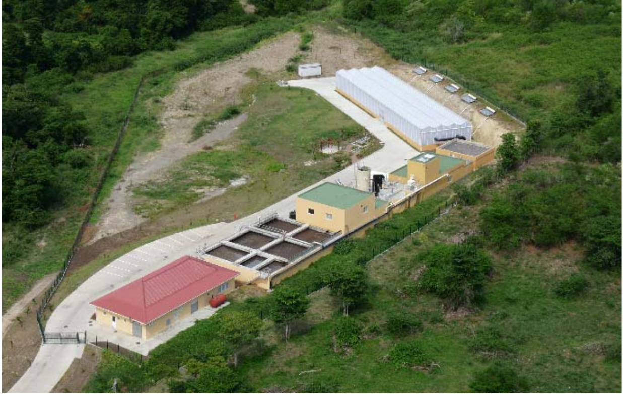
Station d'épuration des 4 Chemins
