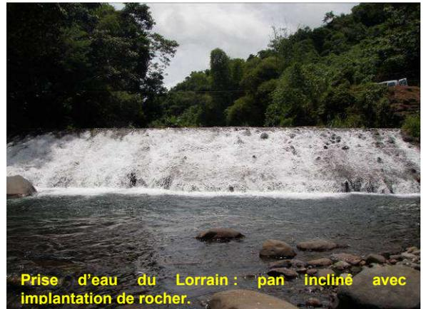
Prise d'eau du Lorrain : pan incliné avec implantation de rocher.
