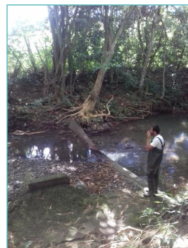
Obstacle à l’écoulement (seuil) observé juste en aval de l’ancien point de mesure. (Oman, aval du pont, 29 Octobre 2018)
