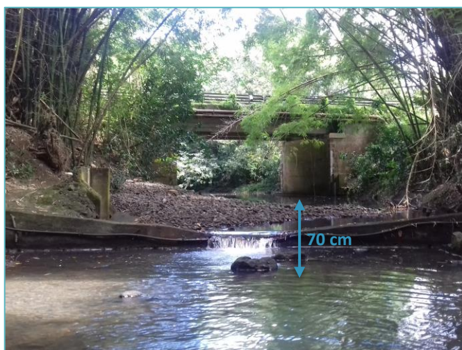
Obstacle à l’écoulement (seuil) observé juste en aval de l’ancien point de mesure. (Oman, aval du pont, 29 Octobre 2018)
